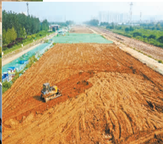
■学苑路隧道上方回填种植土。
