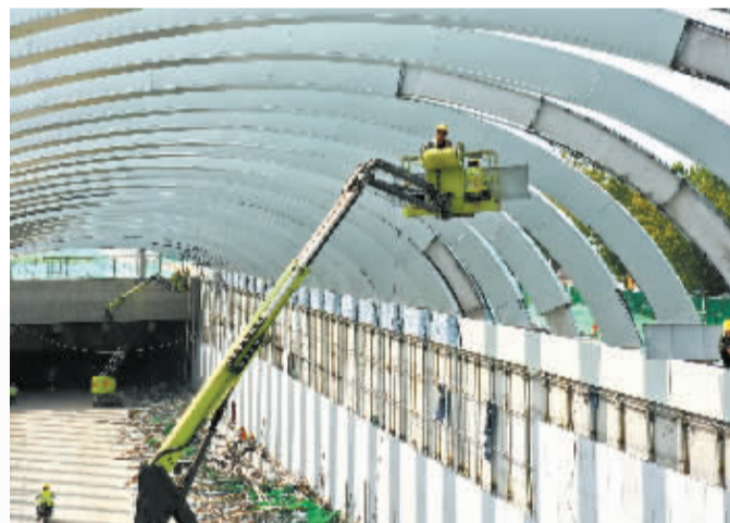
■在白佛隧道出入口,施工人员安装装饰板。
