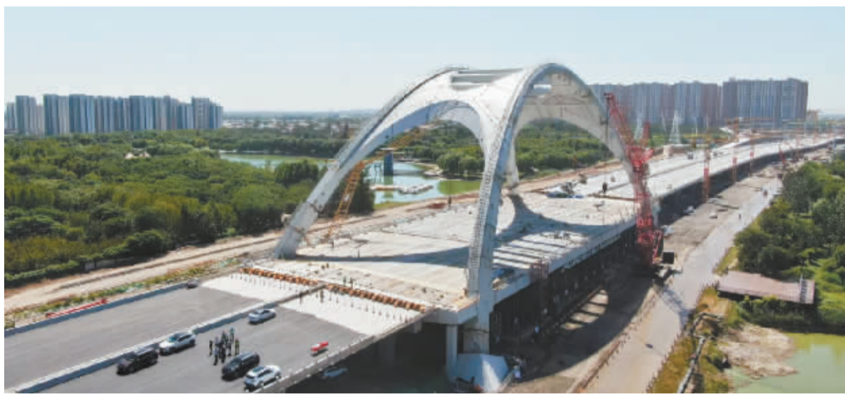
■复兴大街泊水公园特大桥主桥钢箱梁顺利合龙。通讯员 李兴亮 摄
