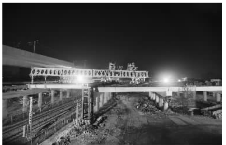
■首片箱梁架设中。通讯员 王天一 摄
