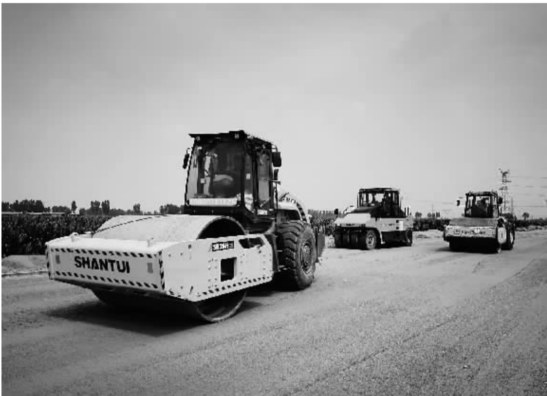
■丰家庄村至北楼村段施工现场。通讯员 王涛 李桂军 摄
