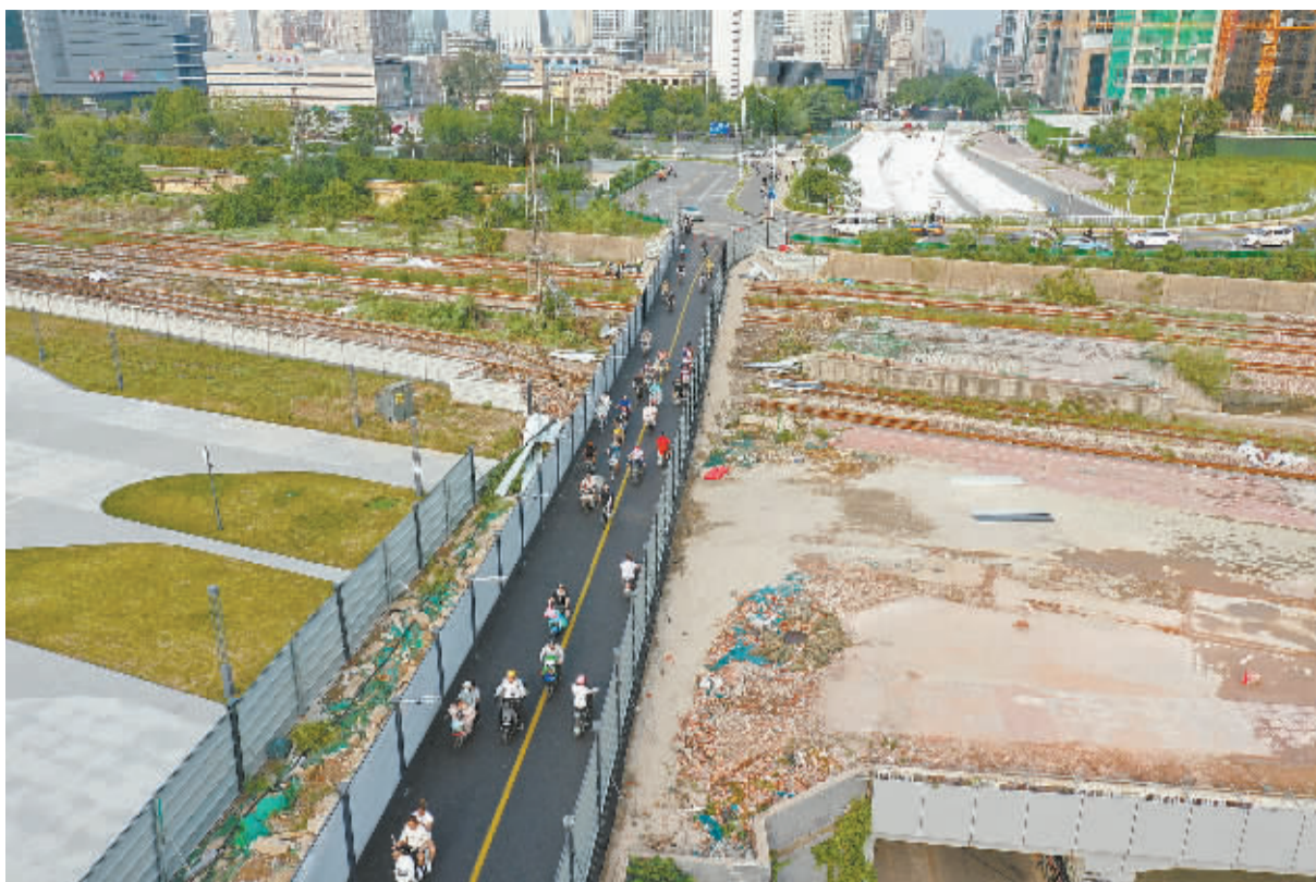
■为方便市民通行,桥上铺设了一条临时非机动车道。
