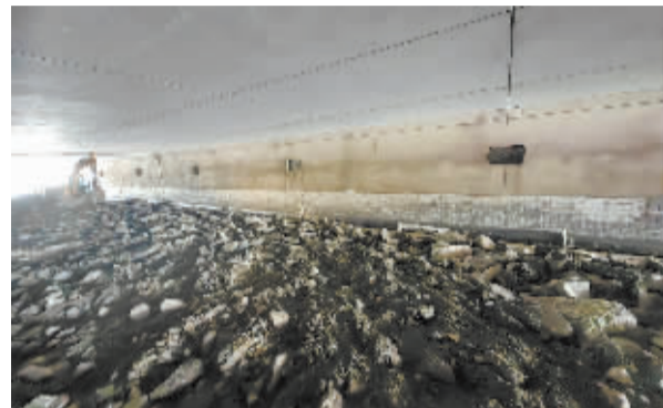
■施工机械破除桥下地面。
