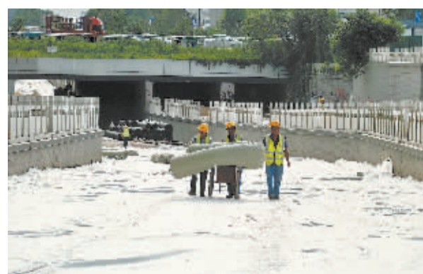
■施工人员正在运送防尘土工布。
