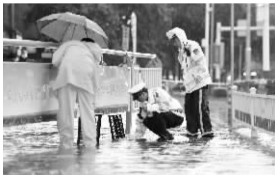
■8月4日下午,石市突降大雨,造成城市部分道路积水。环卫、交管部门工作人员对积水路段进行及时清理,为市民营造安全、畅通的出行环境。图为在中山路与体育大街交口,环卫工人和交警合力清除排水井的杂物。
