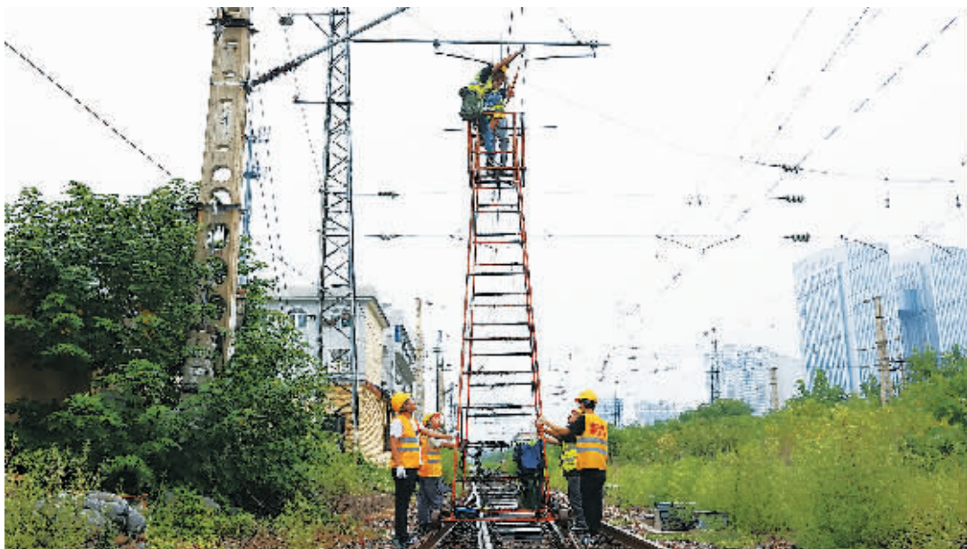
■电力“蜘蛛人”开始拆除胜利大街地面铁路电力接触网。
