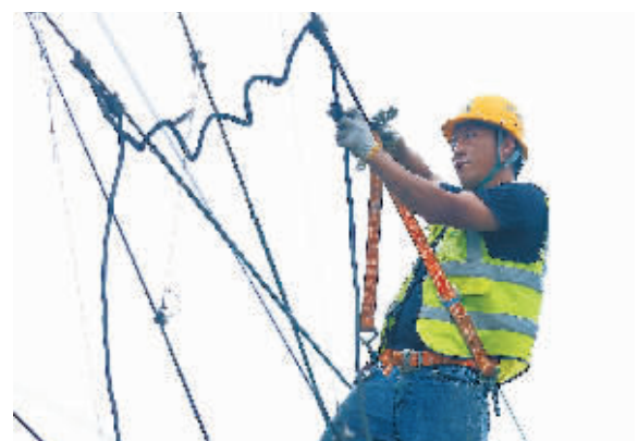
■拆除胜利大街地面铁路电力接触网。
