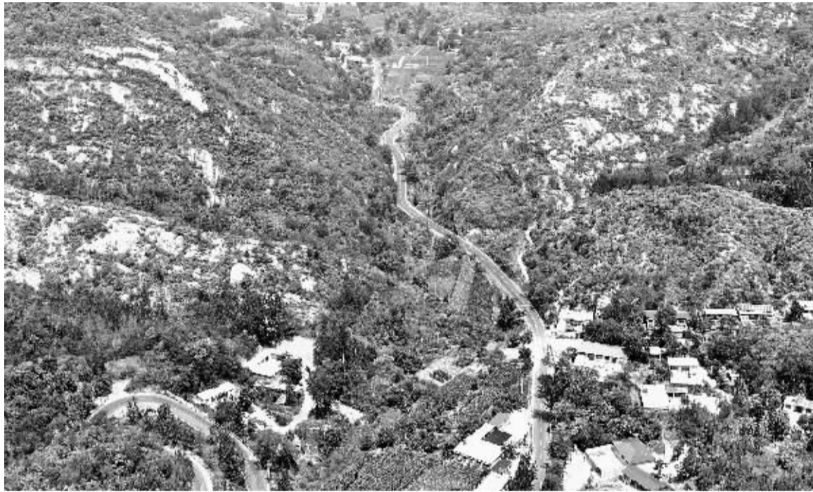
■刚建成通车的灵寿县道陈孟公路,如一条丝带蜿蜒曲折环绕青山。(石市交通运输局供图)
