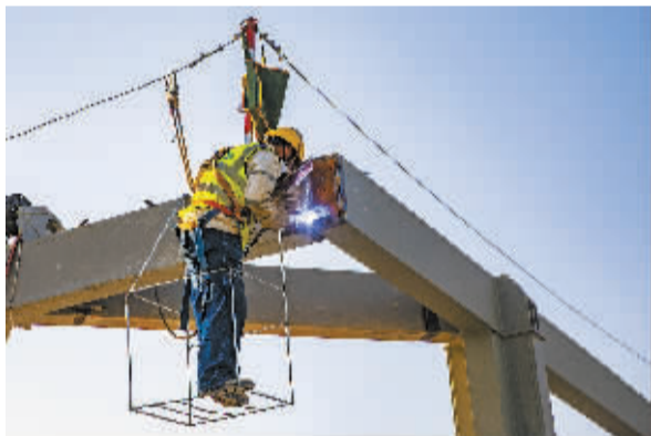
■复兴大街项目建设工地的建设者。于志高 摄
