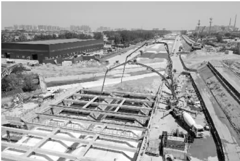
■迎旭门隧道浇筑最后一块顶板。
