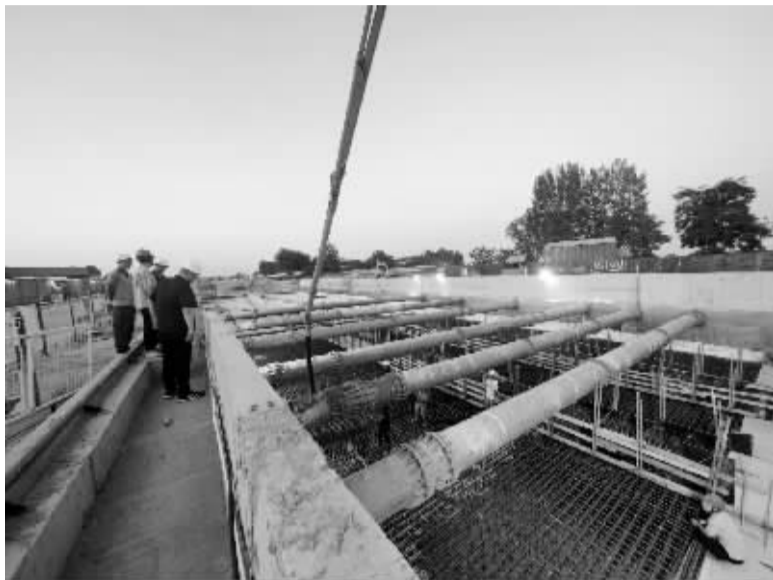
■东洋站最后一块顶板浇筑中。(石市轨道集团提供)
