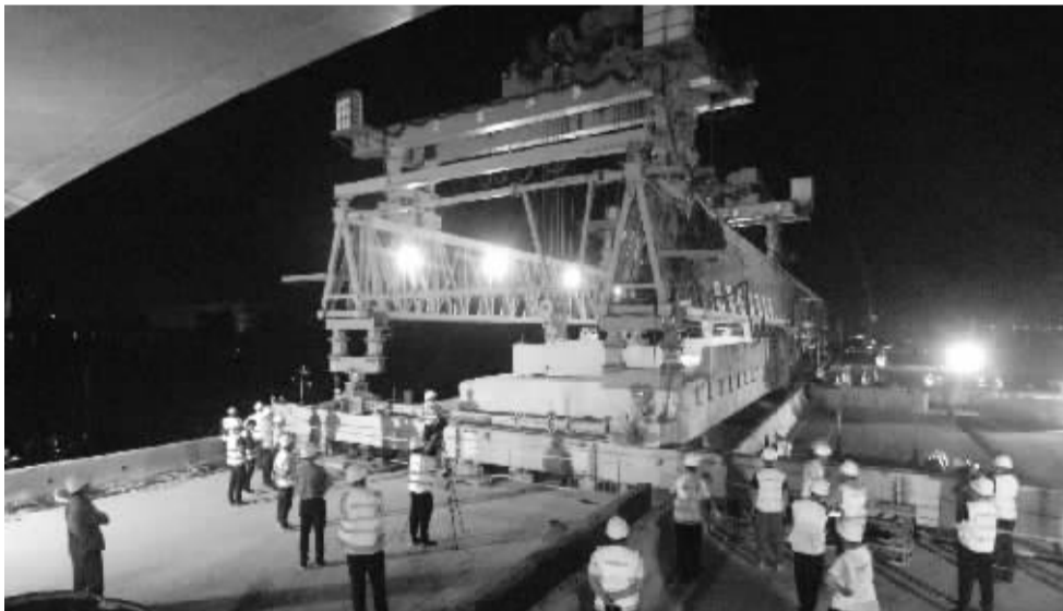
■石家庄市复兴大街上跨石德铁路、下穿石济客专既有桥梁顺利拆除。
