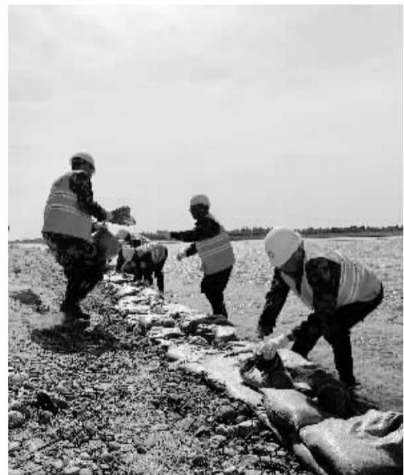
■抢险队员演练用沙袋对大桥桥墩桩基进行二次加固防护。 通讯员 邱雪 摄
