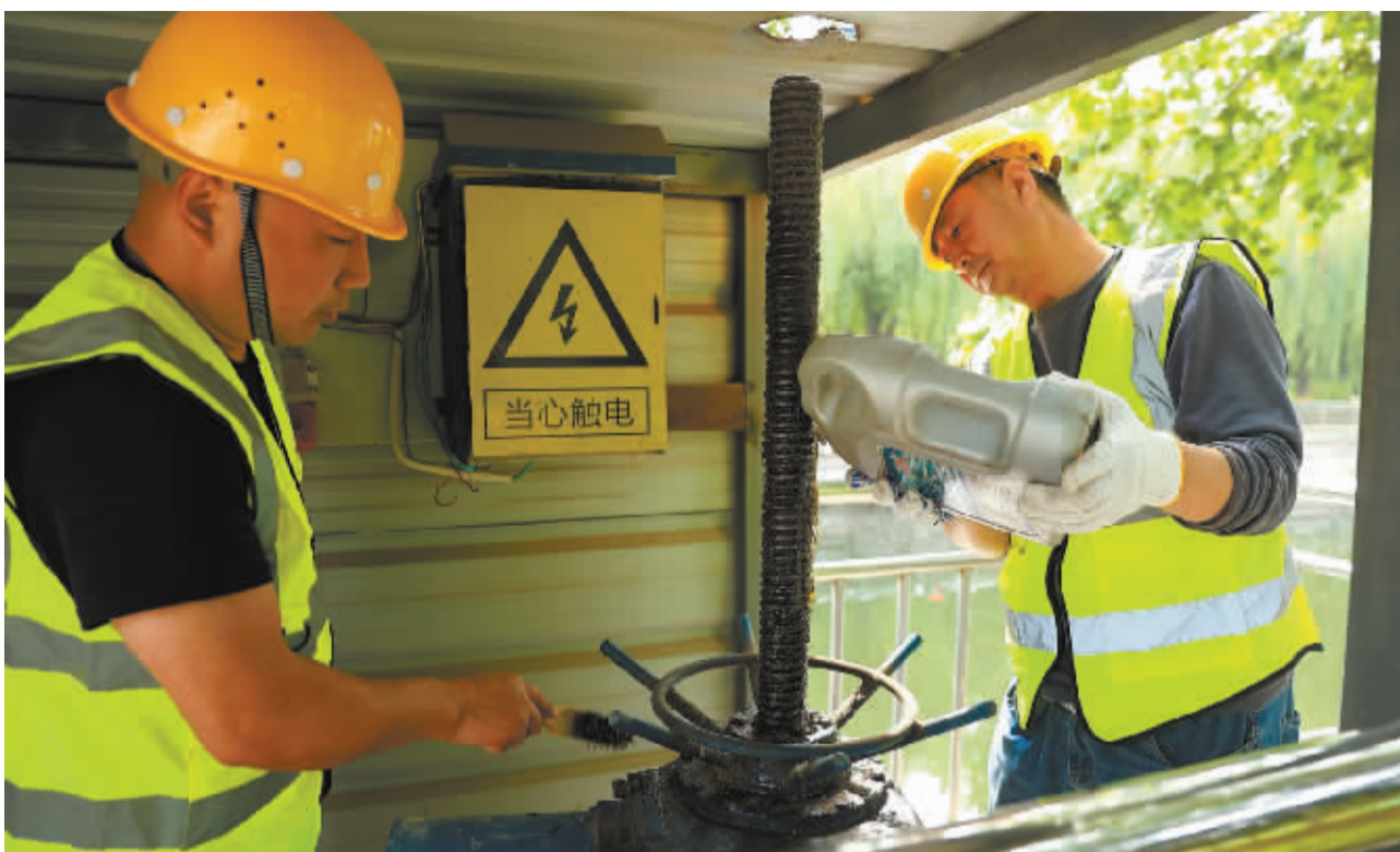
■工作人员对闸门进行检修。
