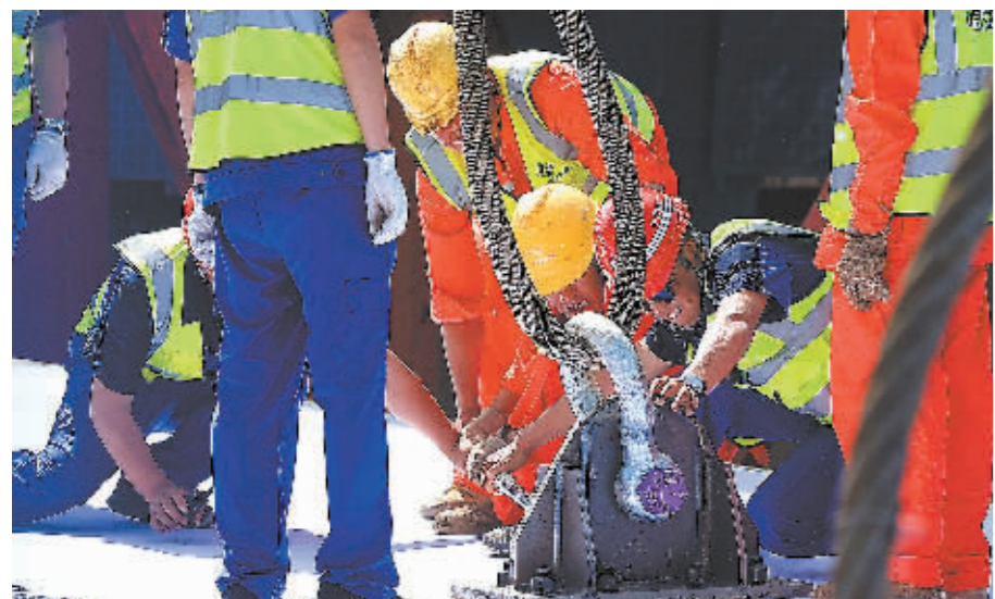
■施工人员正在对高强度吊点螺栓进行检查。
