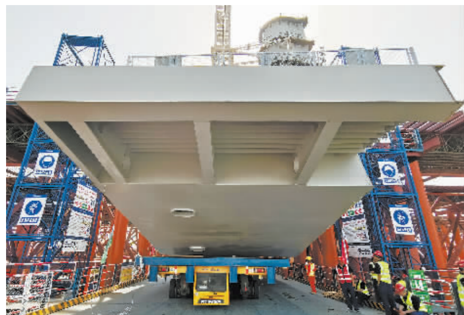
■运梁车将154吨重的钢箱梁运送到位。
