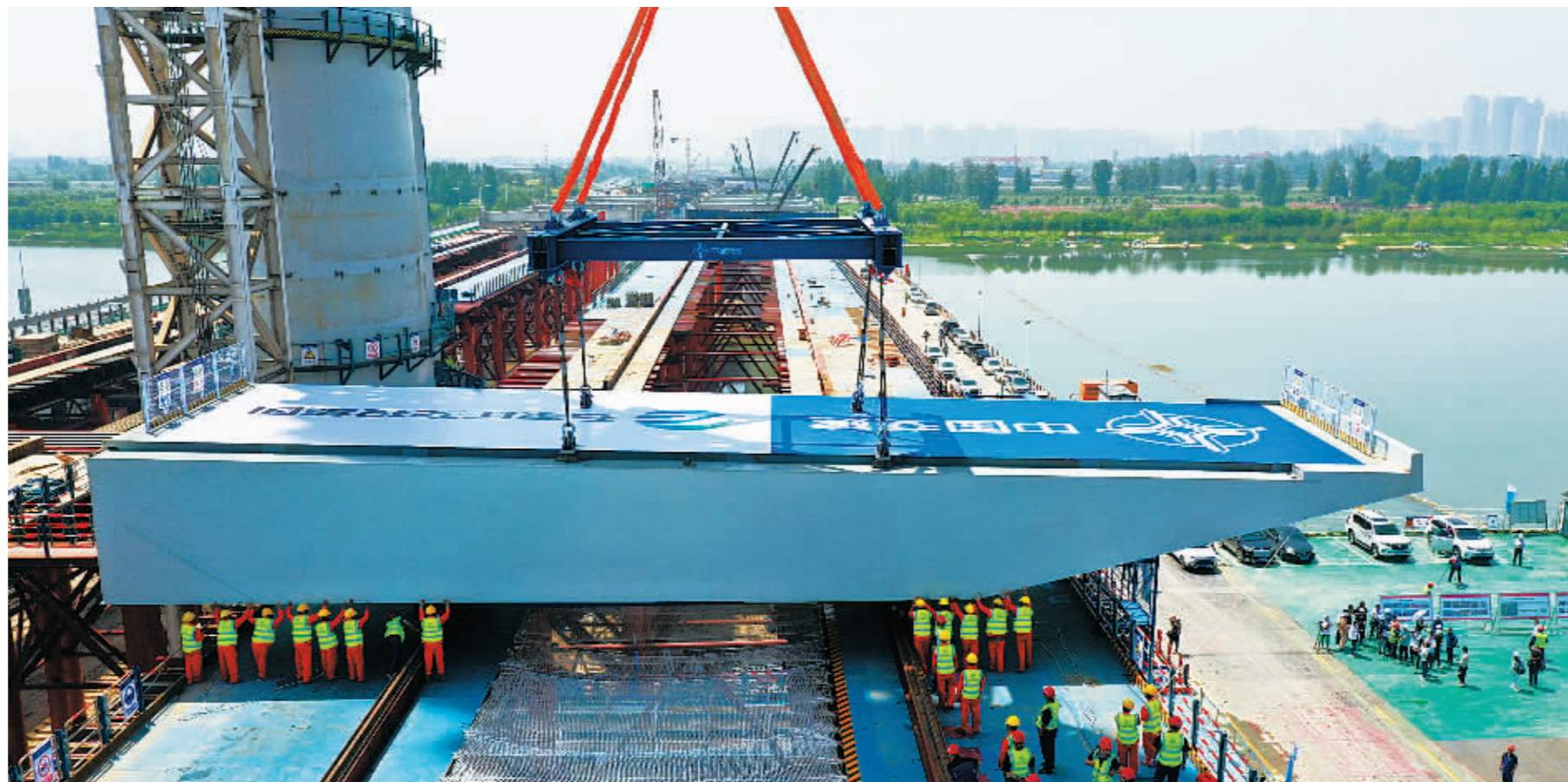
■仅用8分钟，钢箱梁成功吊装至主桥钢梁支架上。
