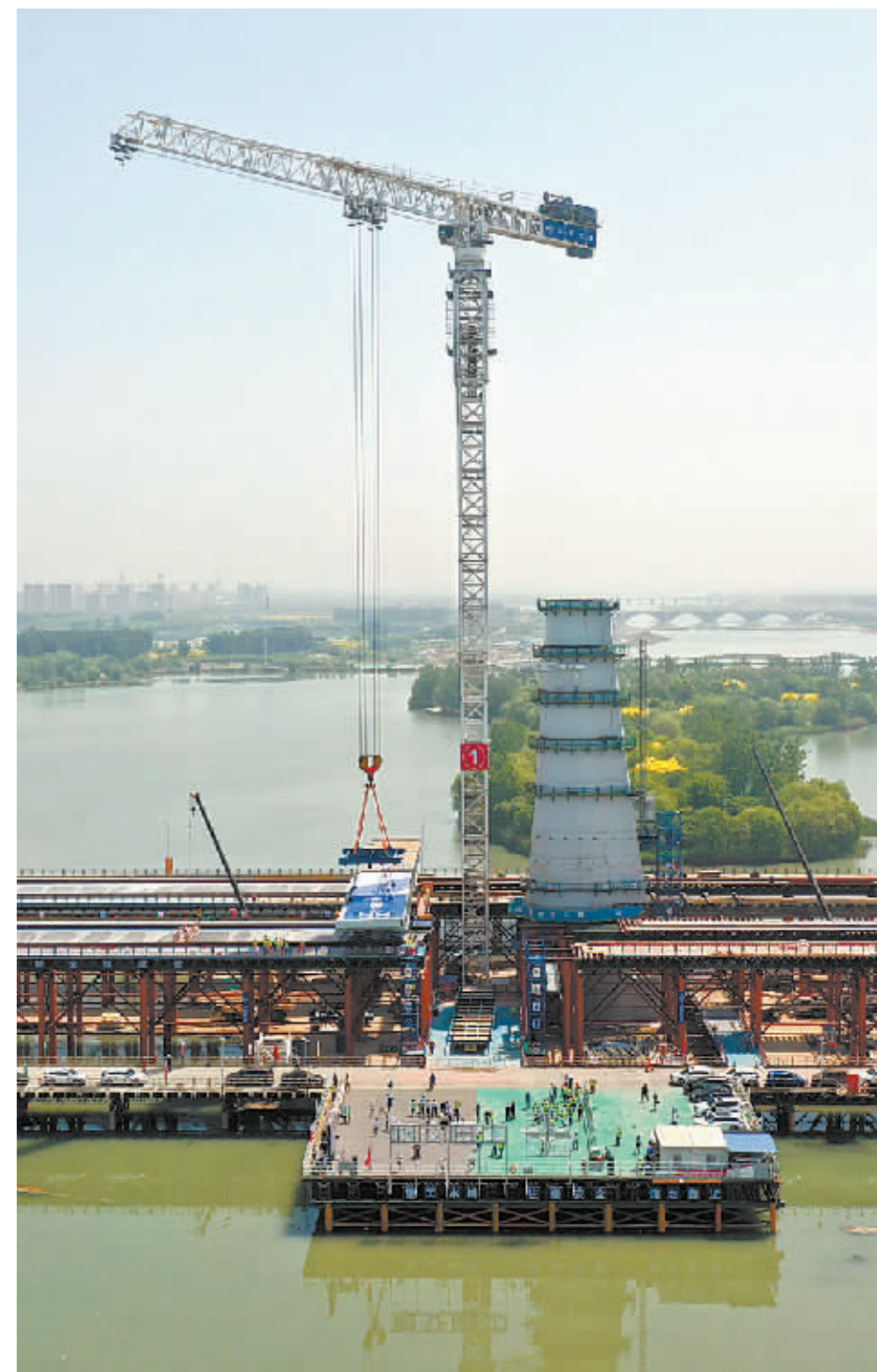
■华北地区最大的STT3930-200吨大型塔吊轰鸣作业，将154吨钢箱梁慢慢吊起。
