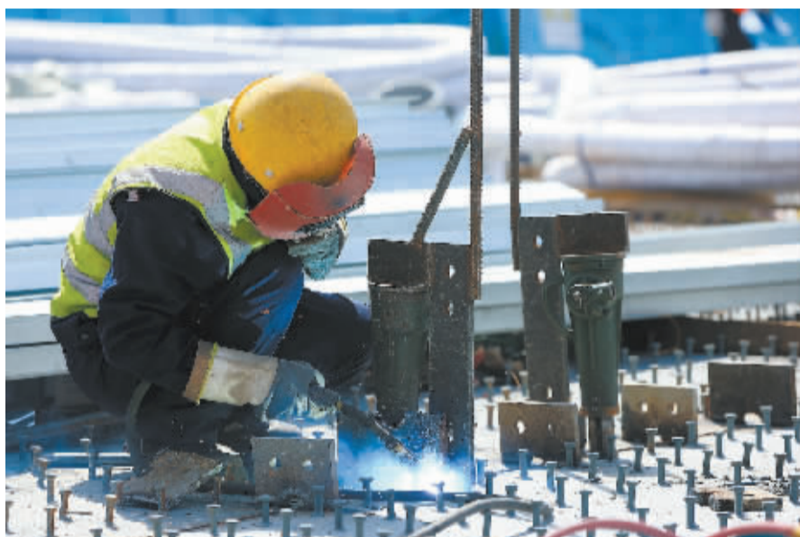
■青年建筑工人进行焊接作业。
