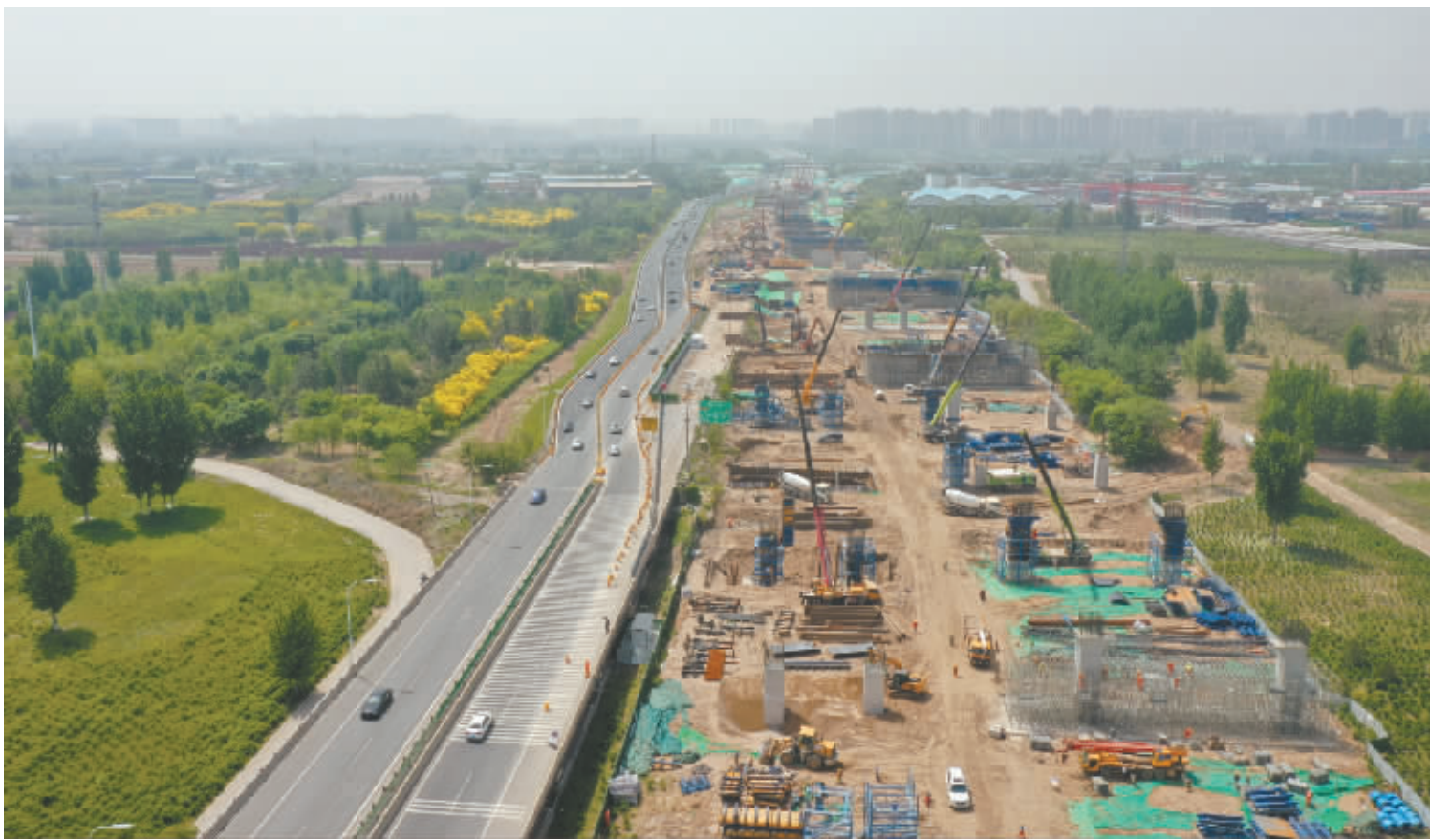
■滹沱河特大桥建设现场。
