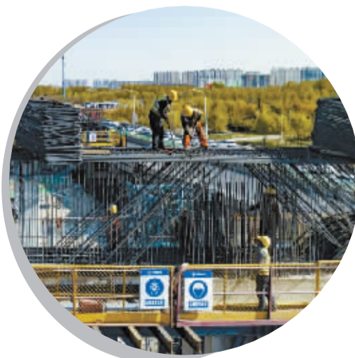
■绑扎盖梁钢筋。
