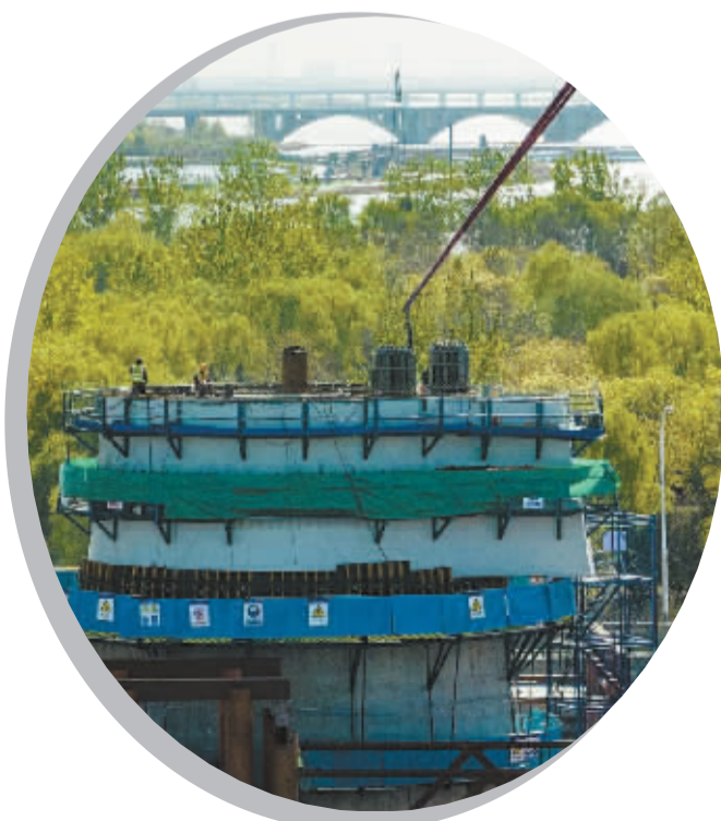
■使用泵车浇筑筑桥主墩钢混结合段。
