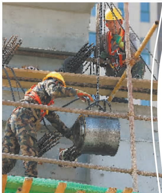
■吊装盖梁张拉设备。
