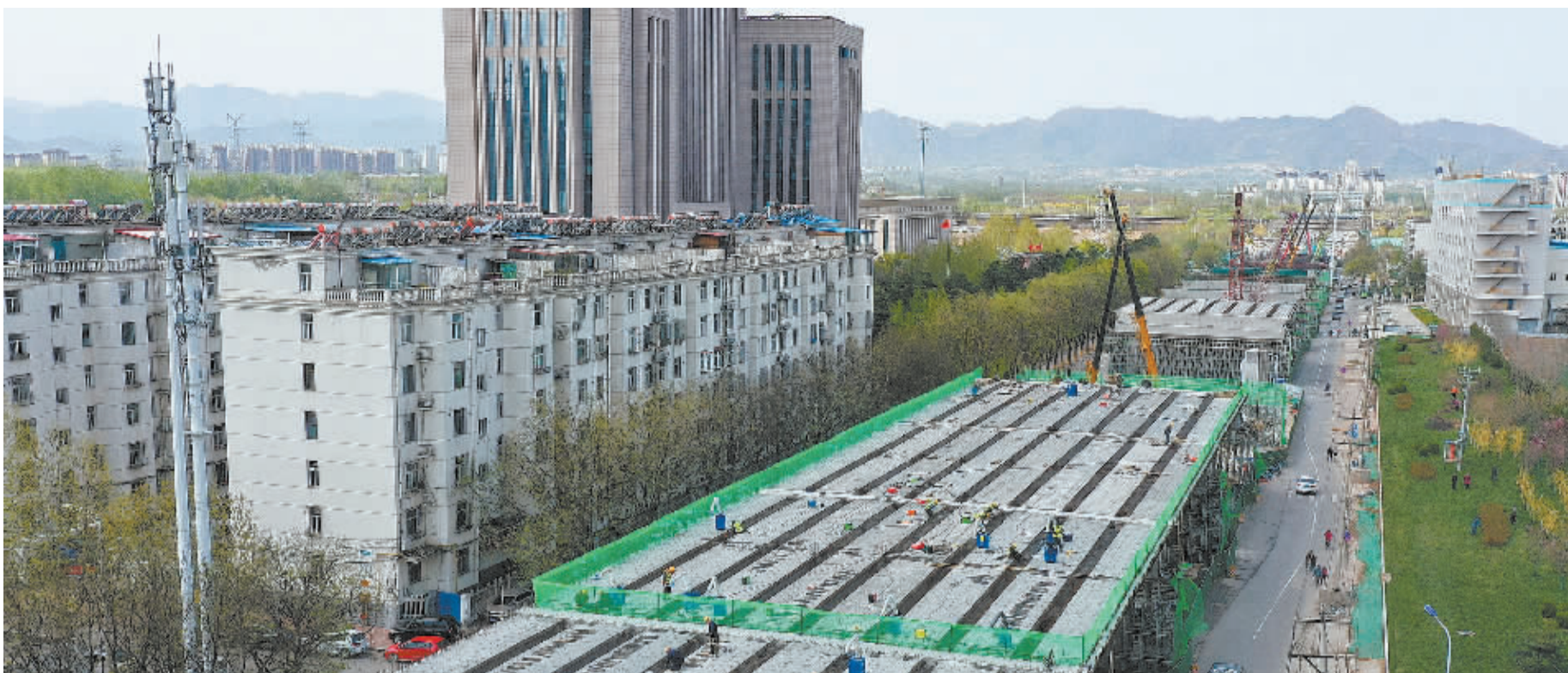
■箱梁紧张搭设中,整个工程有序推进。
