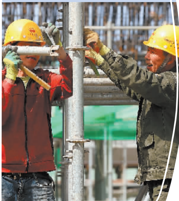
■拆除盖梁下的盘扣架。
