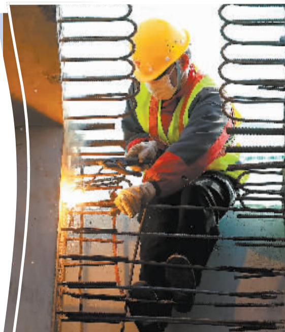
■焊接箱梁横隔板钢筋。
