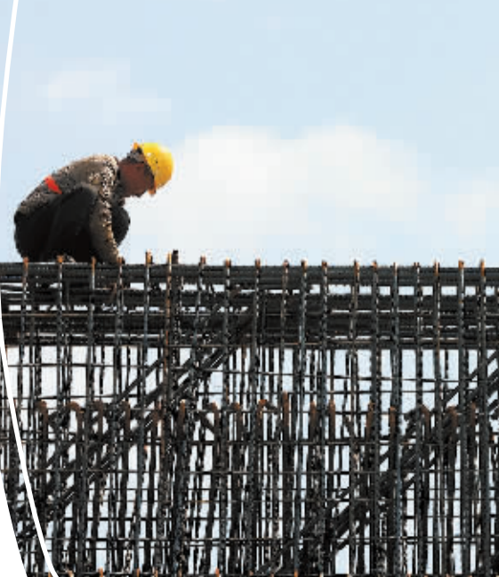
■加工盖梁钢筋。
