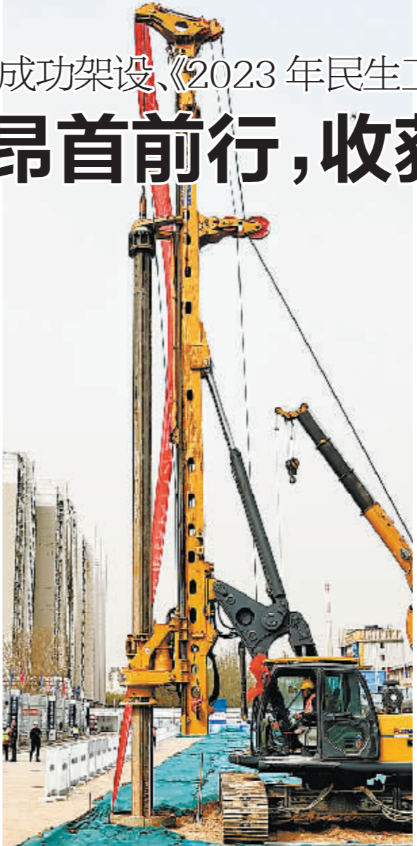
■3月23日上午，石家庄市轨道交通5号线一期工程打下第一根桩基。本报记者 张海强 摄
