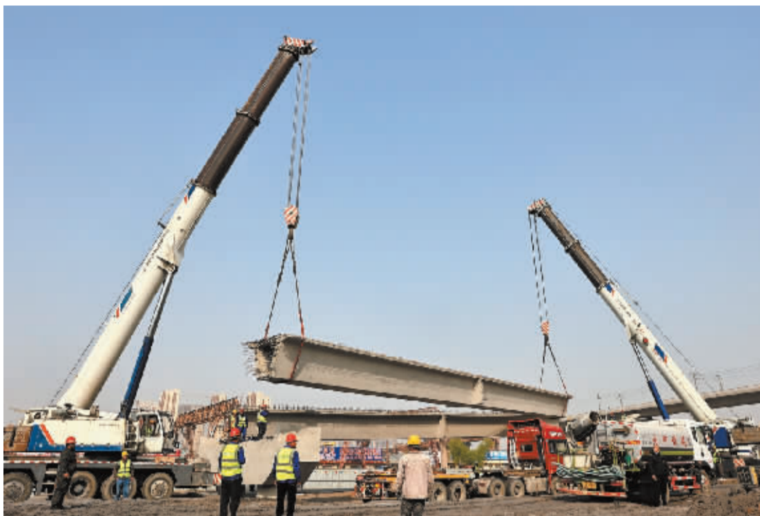
■两台起重机吊起 30 米长、99 吨重的首片箱梁。
