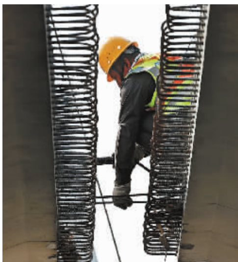
■焊接固定箱梁。
