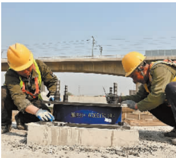
■施工人员正在固定桥梁支座。
