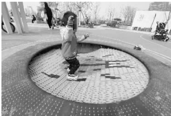
■拾光智慧体育公园里儿童蹦床部分已经塌陷。
