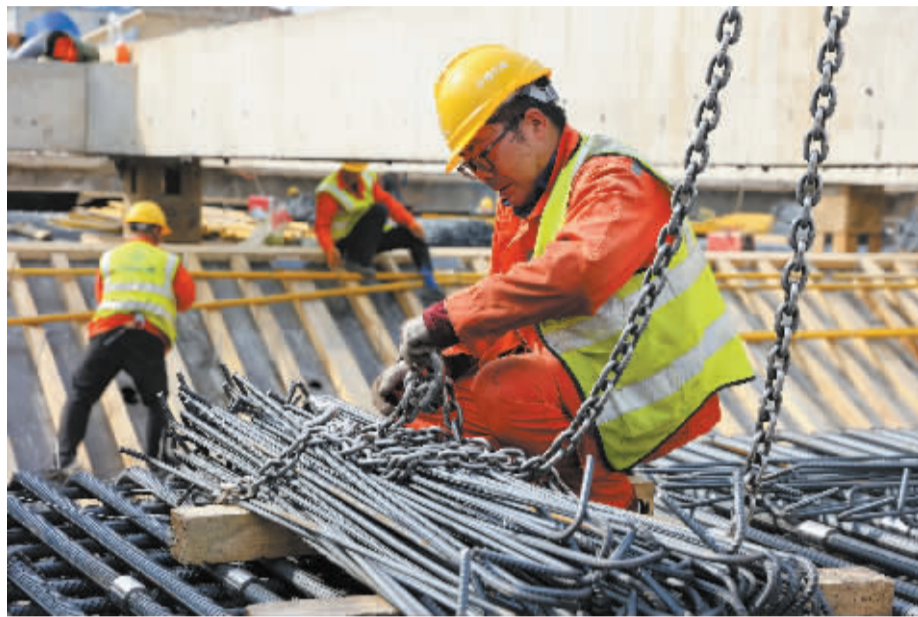
■施工人员正在进行钢筋吊装。
