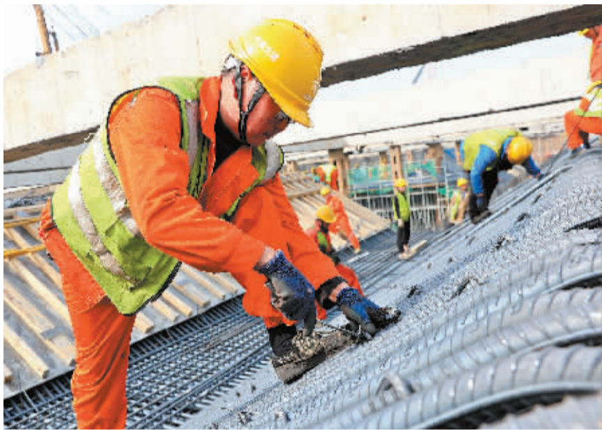
■施工人员正在进行钢筋绑扎。
