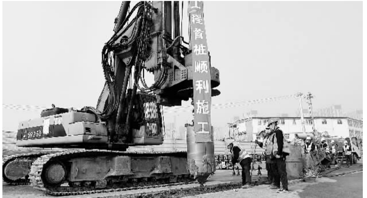
■4号线一期工程打下第一根桩基。
