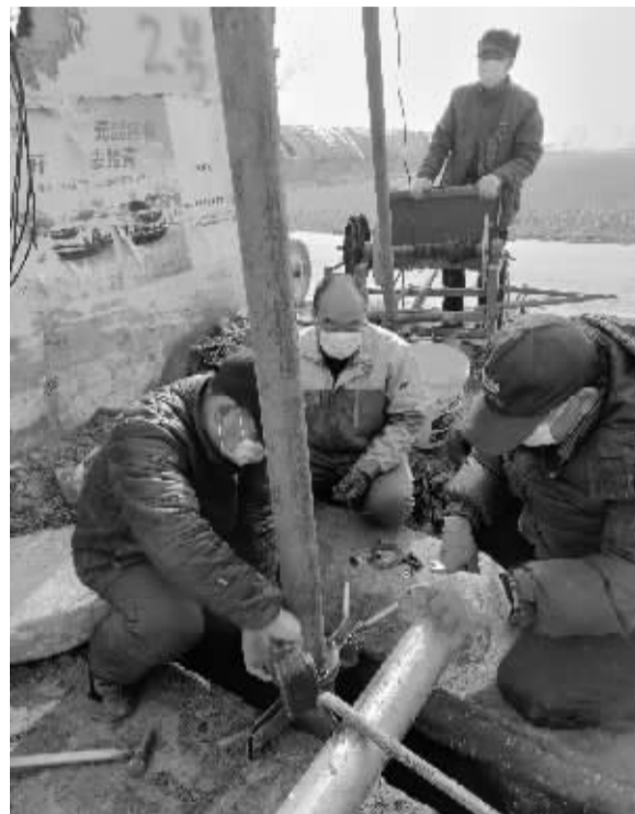
■马素峰(左二)和施工人员一起更换水泵。
