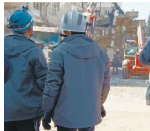
■大型机械进入现场,开始清除大块障碍物。
