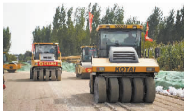
■石衡高速建设现场。本报记者 张海强 摄
