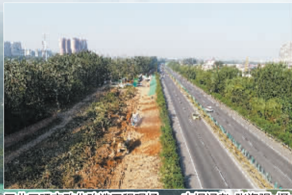
■北三环市政化改造工程现场。 本报记者 张海强 摄
