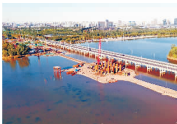
■滹沱河特大桥开工建设。（交投集团供图）
