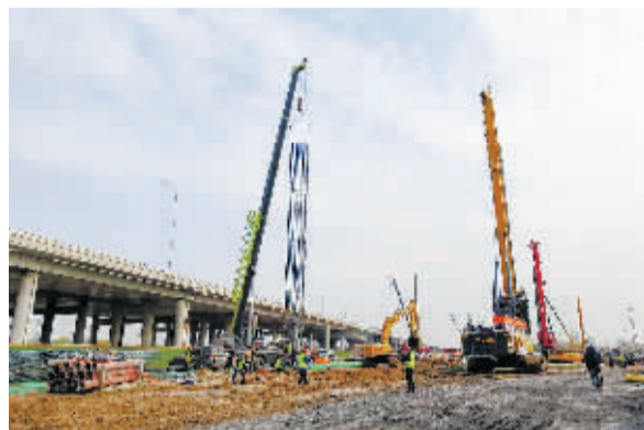
■复兴大街与新城大街互通立交热火朝天的施工现场。 本报记者 冯月静 摄
