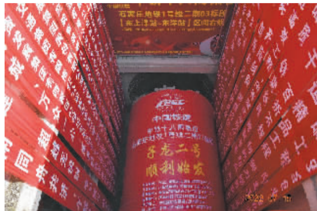
■地铁1号线二期北段盾构始发现场。
