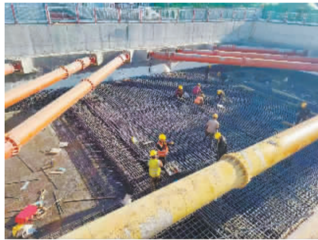
■地铁施工现场。通讯员 田张梦 摄
