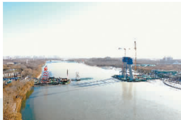
■学府路东延跨太平河桥梁工程加速建设中。本报记者 张海强 摄
