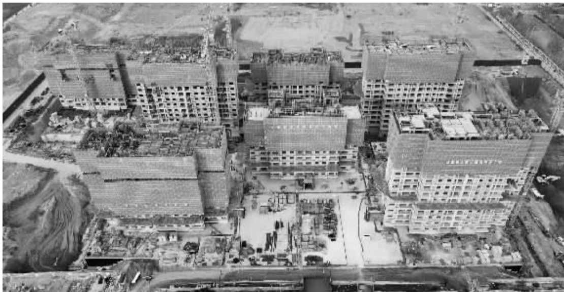
■前太保城中村改造项目全速推进中。(城发投集团供图。)
