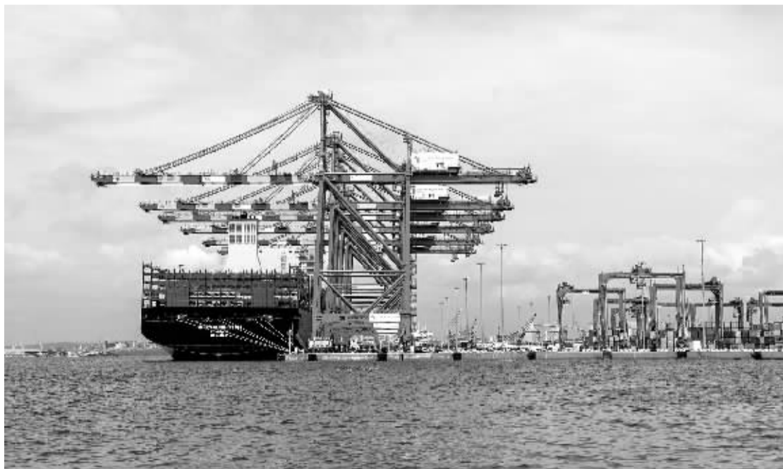
■由中国港湾工程有限责任公司承建的科特迪瓦阿比让港第二集装箱码头2日正式开港。据了解,科特迪瓦阿比让港第二集装箱码头自2015年启动建设,共有3个15万吨级码头泊位,岸线全长1312米,将使阿比让港年吞吐量从120万提升至250万个标准集装箱。图为12月2日拍摄的科特迪瓦阿比让港第二集装箱码头。 新华社记者 郑扬子 摄
