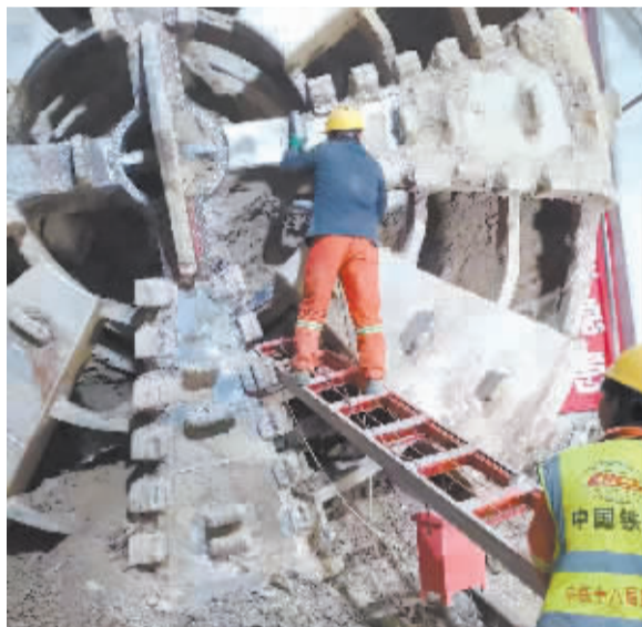
■工作人员对盾构机进行维修调试。(中铁十八局供图)
