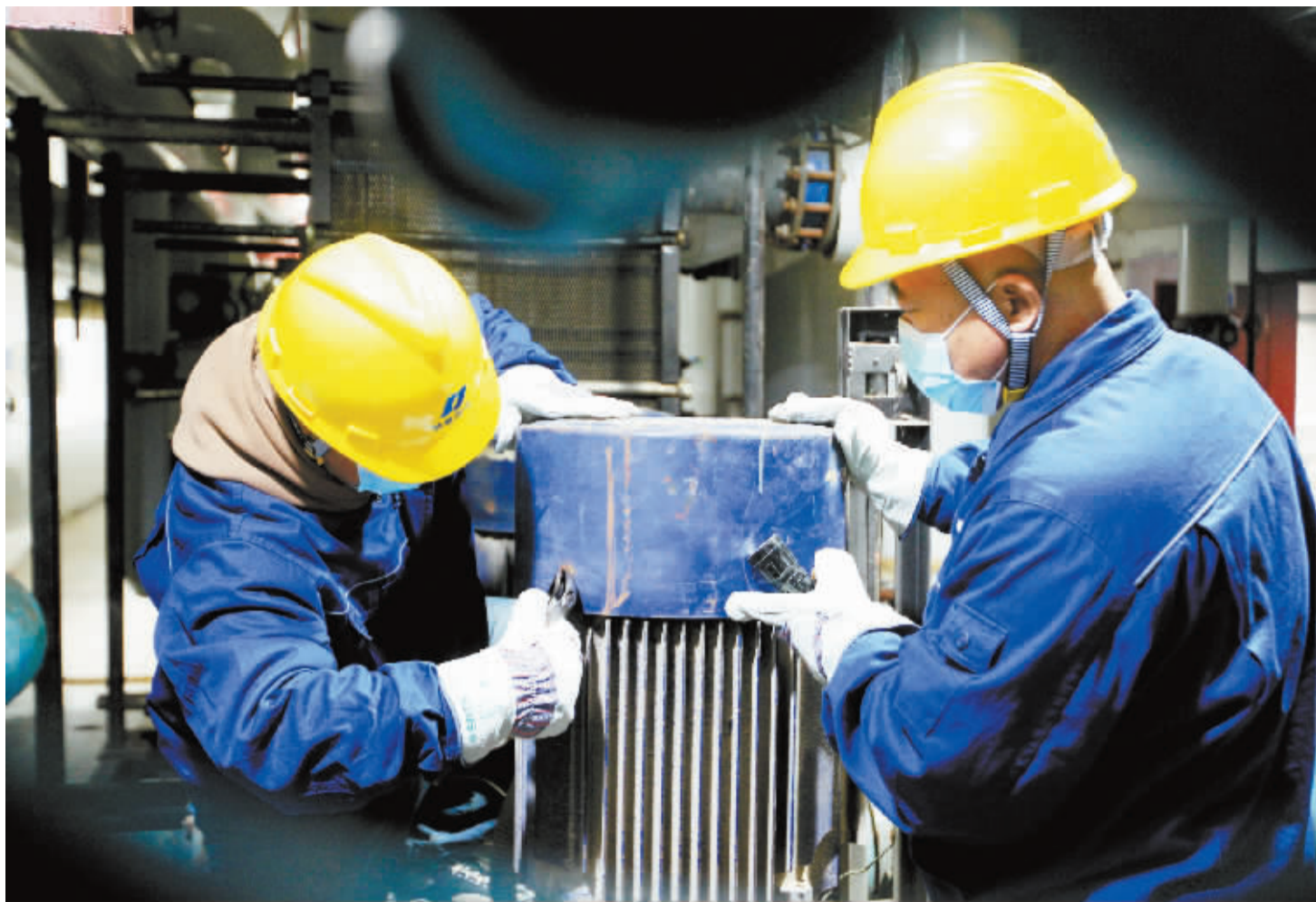
■对二次网循环泵电机进行检修。
