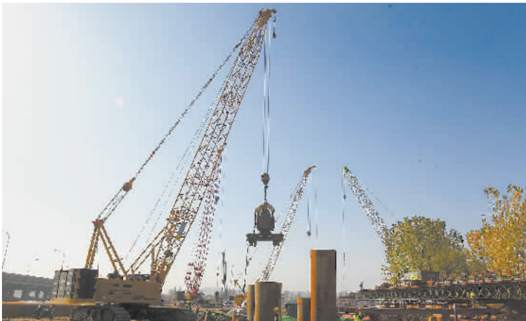
■ 正在安装钢护筒。
