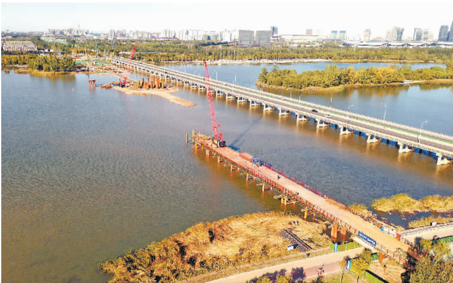
■ 滹沱河特大桥项目施工现场。
