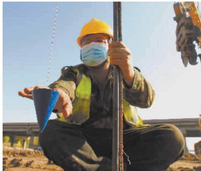
■ 施工人员使用线坠检查安装的钢护筒是否跟地面垂直。
