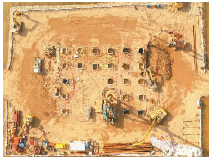
■ 滹沱河特大桥主墩施工现场。
