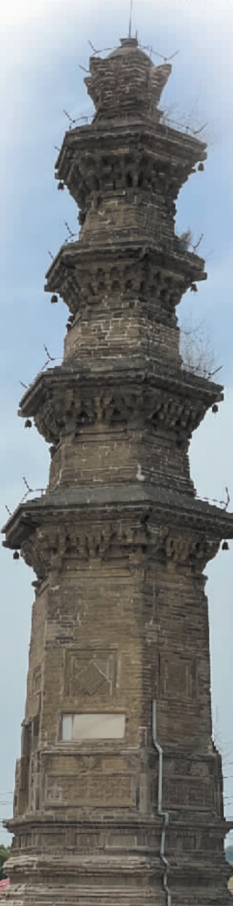
■西林寺塔近景。
