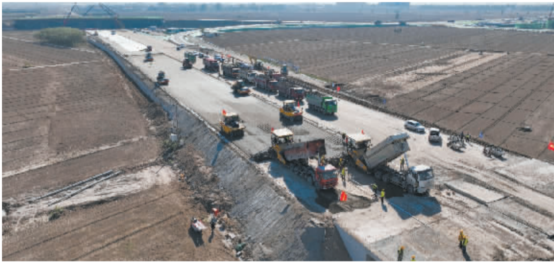
■石衡高速建设正在全力推进中。
