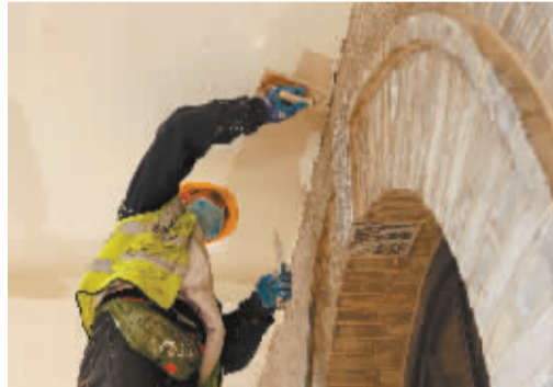
■施工人员正在修理墙面。
