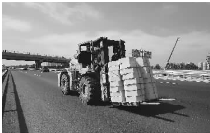
■国文成老师拍摄的复兴大街市政化改造项目照片。
