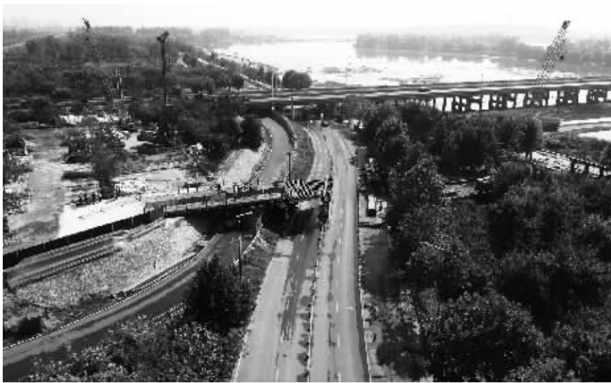
■建设中的滹沱河特大桥。本报记者 张海强 摄
