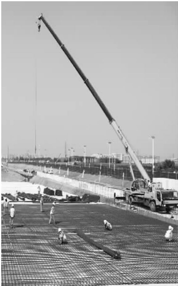
■复兴大街市政化改造项目城市基础设施提升工程一工区掀起大干快上热潮。 本报记者 张海强 通讯员 谢峰 摄
