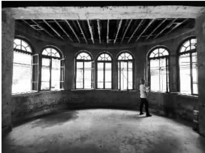
■工作人员正在查看房屋窗户修复情况。
