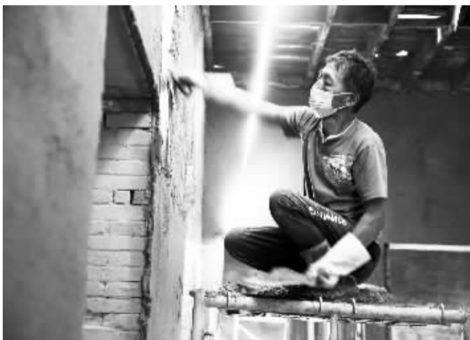
■施工人员正在内部施工。
