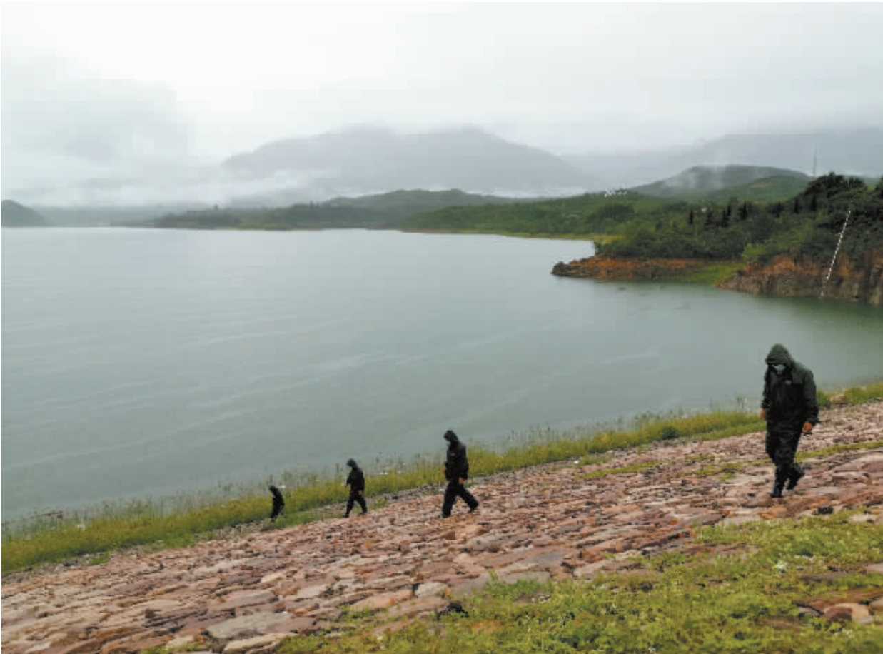
■工作人员正在对白草坪水库大坝进行拉网式巡查。
