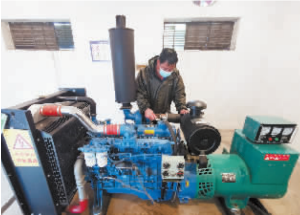
■工作人员正在检查发电设备。
