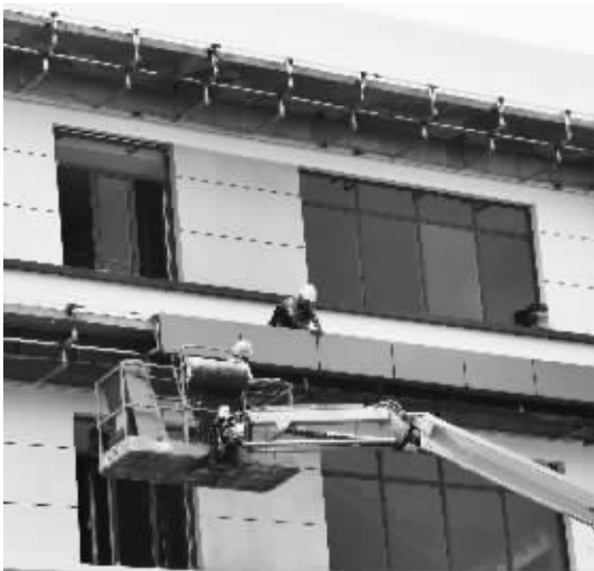
■莲池区第一实验小学分校正在进行最后的施工。
