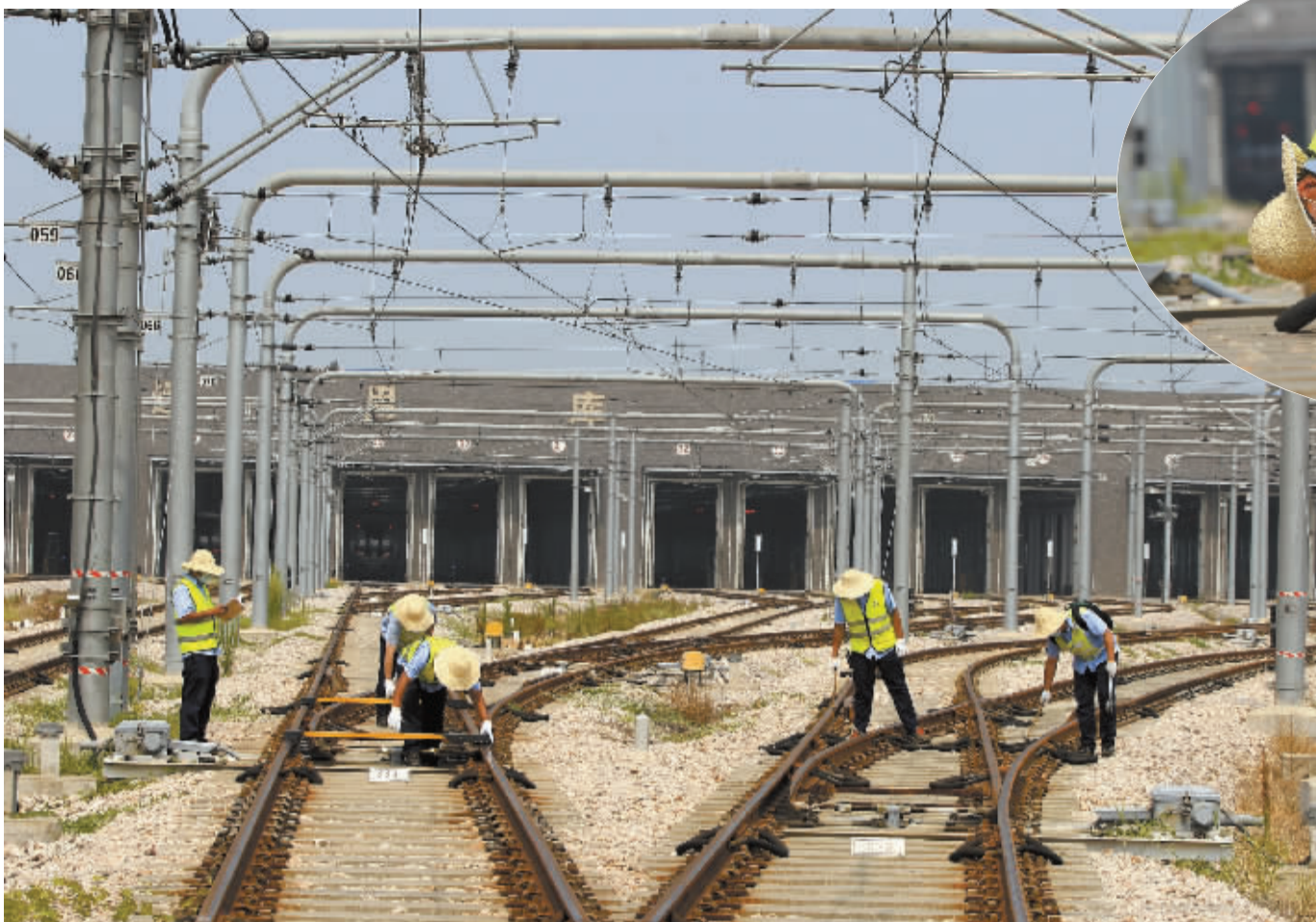
■轨道检修人员在烈日下进行日常巡检作业。
