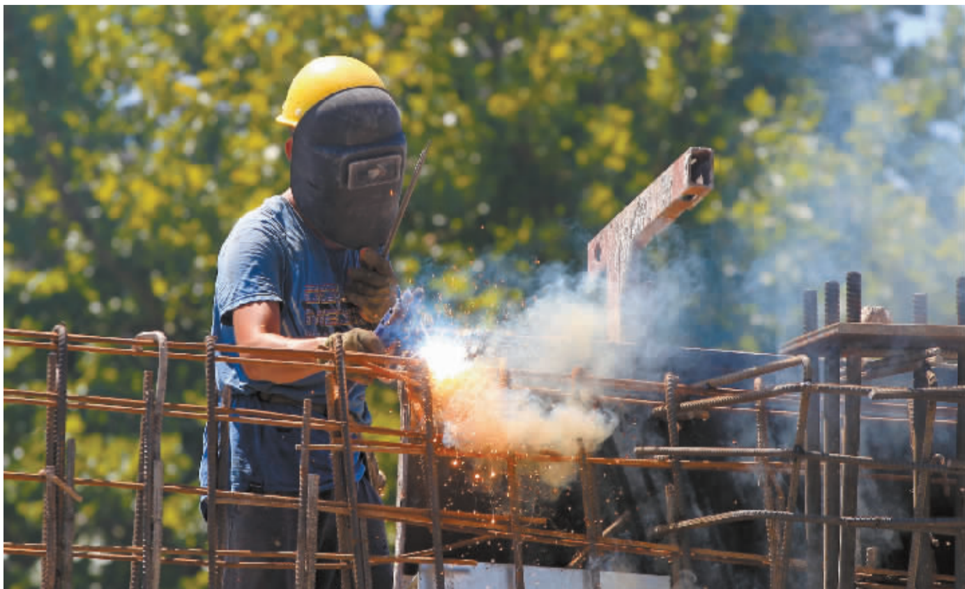
■高温下作业的电焊工人。
