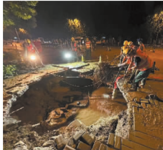
■爆管抢修现场。通讯员 安柔 摄
