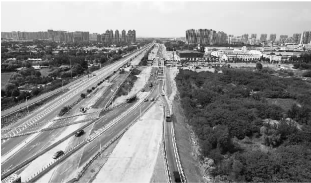
■复兴大街市政化改造项目白佛隧道段保通路通车。
