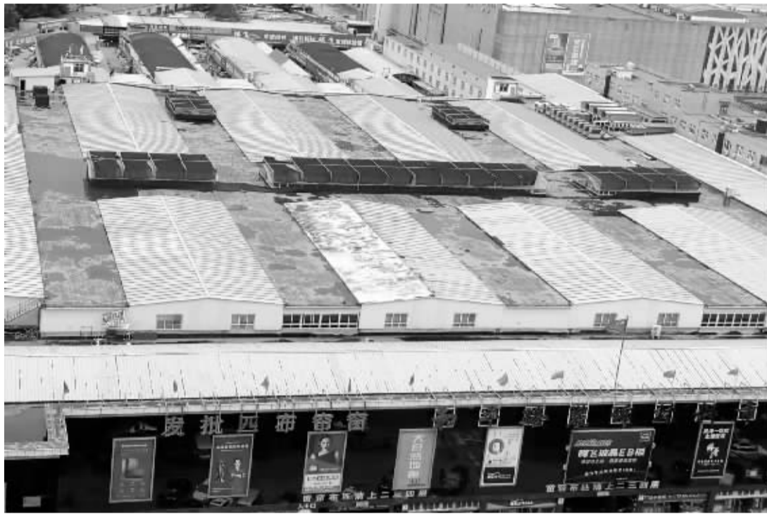
■铺设了反光防水材料的屋顶。本报记者 陈思帆 摄
