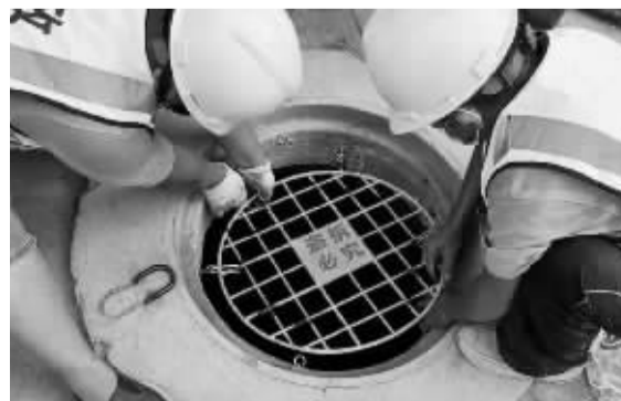
■施工人员正在安装防坠架。 通讯员 屈鲲 摄
